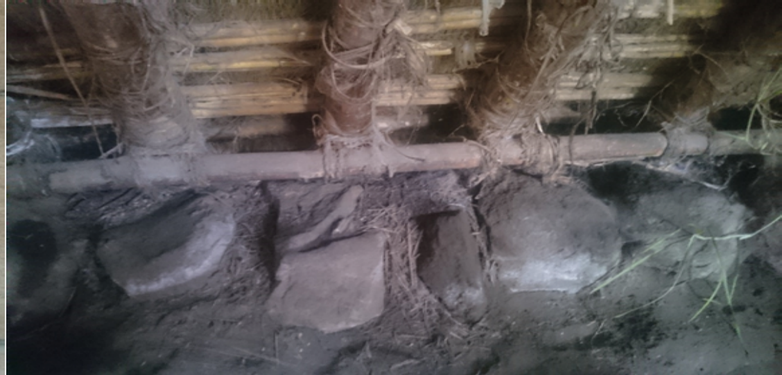
Figura 1-19 Foto del detalle de base del muro- cubierta sobre cimentación de piedra. Autor: autora y equipo de apoyo
