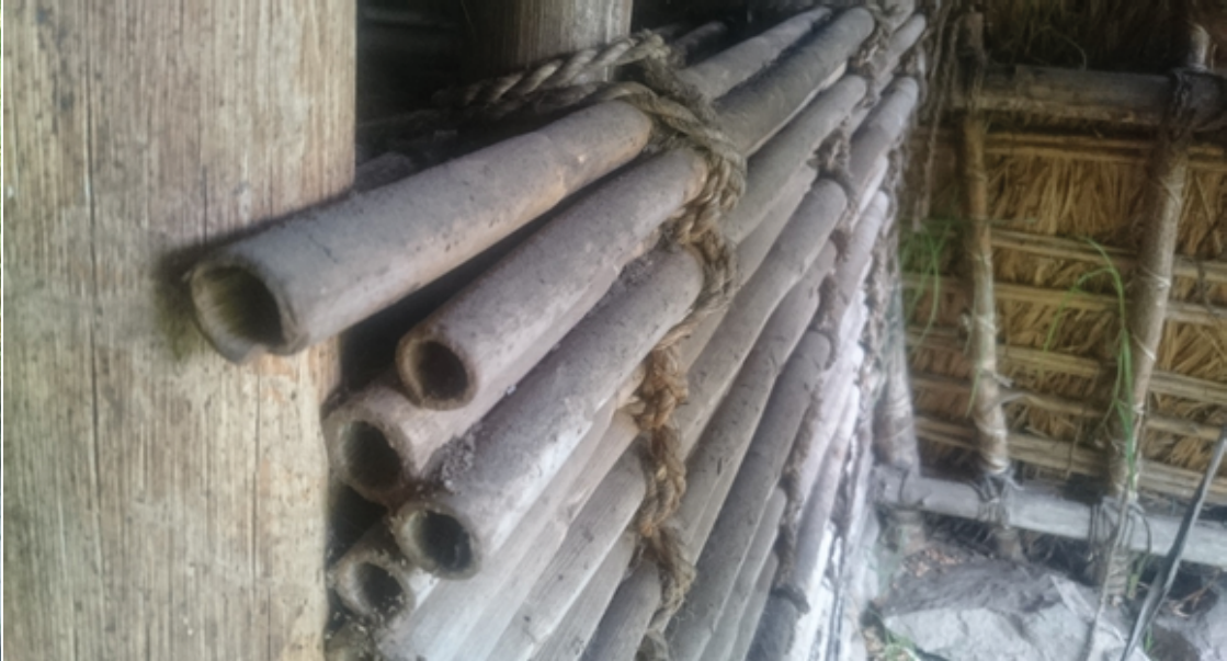
Figura 1-15 Foto del detalle de tabiquería interior divisoria entre corredor frontal y espacio privado. Autor: autora y equipo de apoyo
