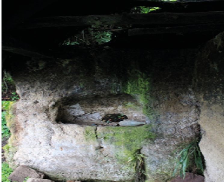
Figura 1-27 Foto de choza con perforaciones en el muro de tapial para depósito de objetos, se observan también hacia el interior. Autor: autora y equipo de apoyo.
