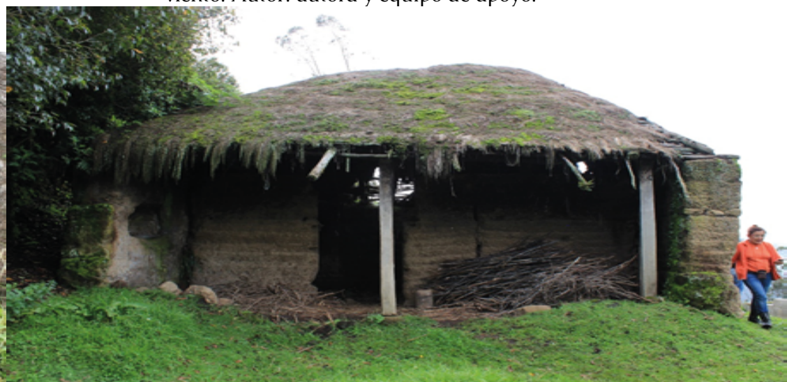
Figura 1-26 Foto de choza con perforaciones en el muro de tapial para depósito de objetos, se observan también hacia el interior. Autor: autora y equipo de apoyo.
