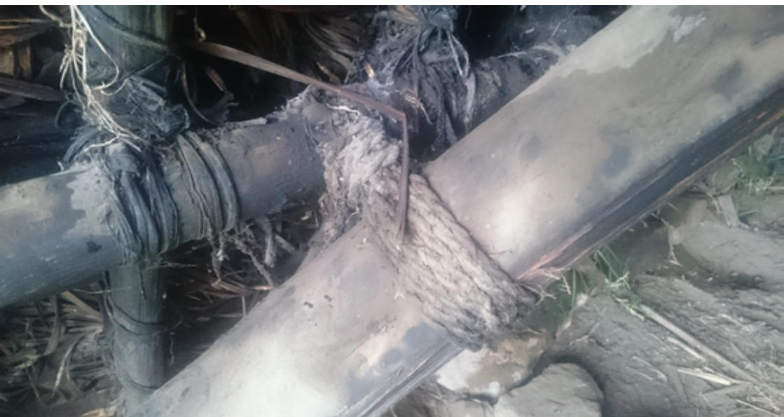
Figura 1-14 Foto del detalle de sujeción de contrafuerte a elementos verticales. Autor: autora y equipo de apoyo
