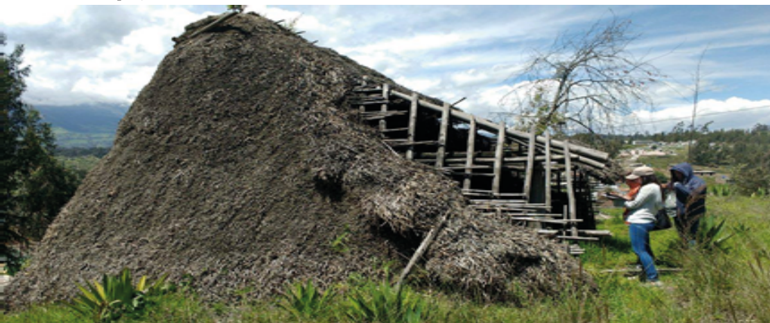
Figura 1-28 Foto de choza donde se aprecia la estructura de chaguarquero y carrizo. Autor: autora y equipo de apoyo
