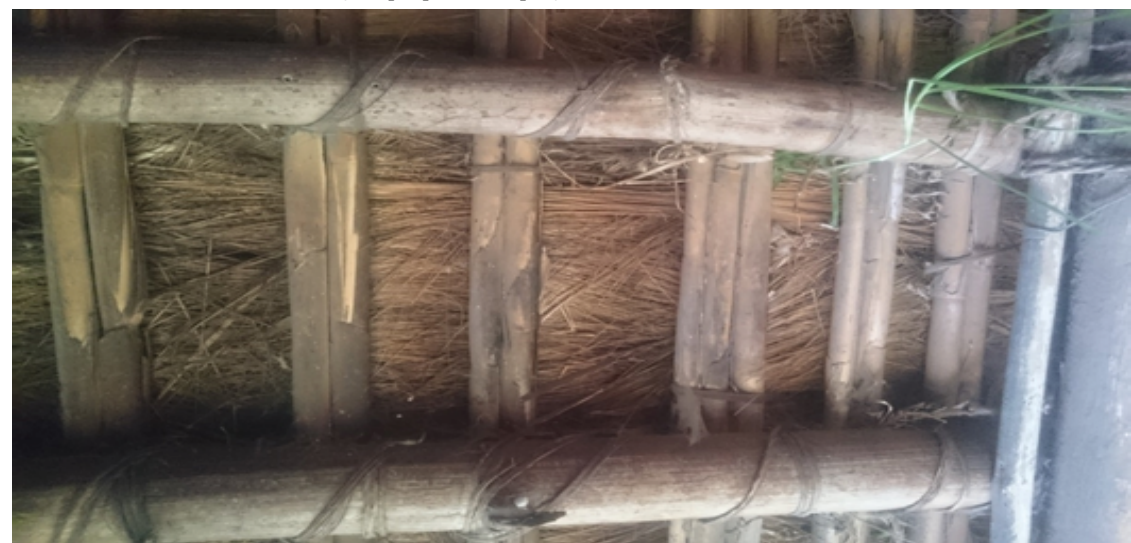
Figura 1-12 . Foto del enchagllado. Autor: autora y equipo de apoyo
