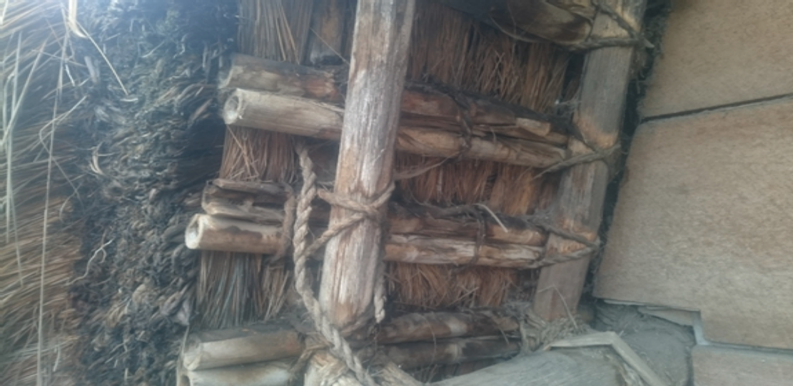
Figura 1-17 Foto del detalle de alero en cubierta. Autor: autora y equipo de apoyo
