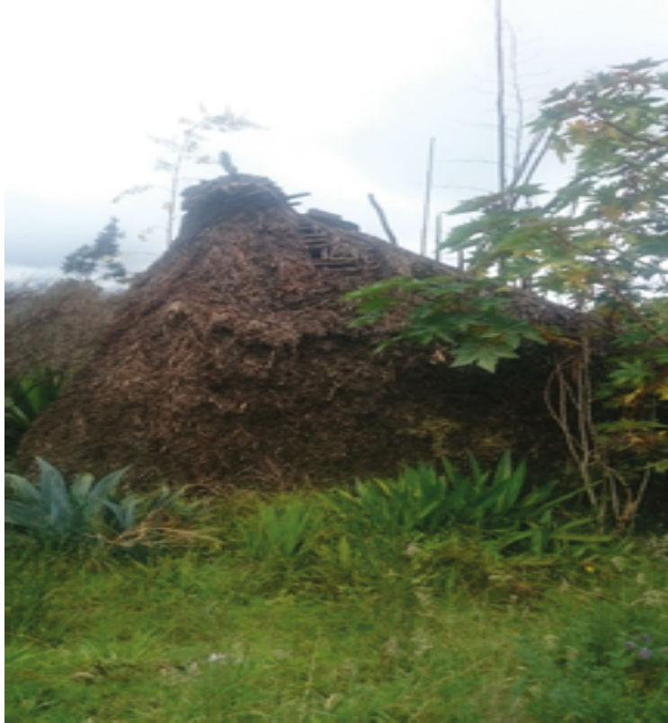
Figura 1-21 Foto donde se observa el remate característico de la vivienda Puruhá, el humo se evacúa por la parte superior de la forma piramidal de la vivienda. Autor: autora y equipo de apoyo
