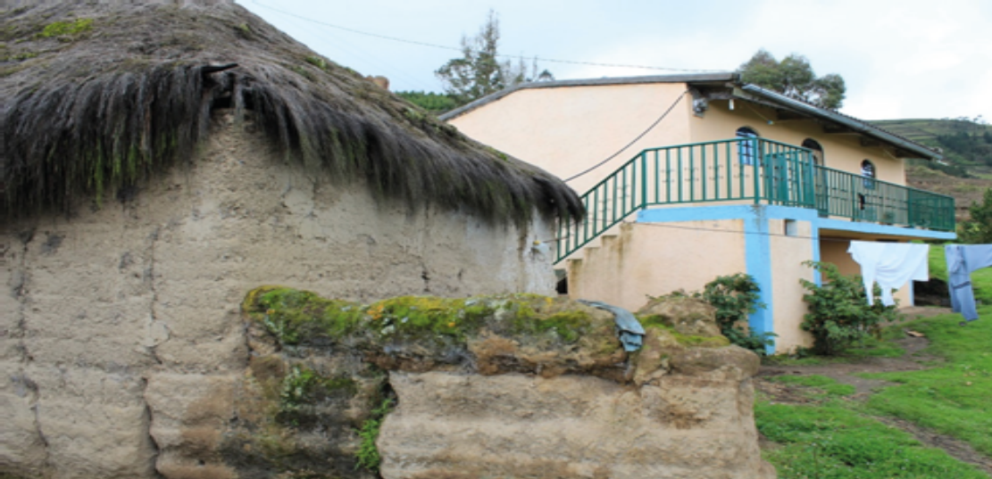
Figura 1-23 Foto de vivienda en plataforma excavada sobre la pendiente de la montaña, la vivienda es con mampostería de tapial, parroquia Punín cantón Riobamba. Autor: autora y equipo de apoyo.
