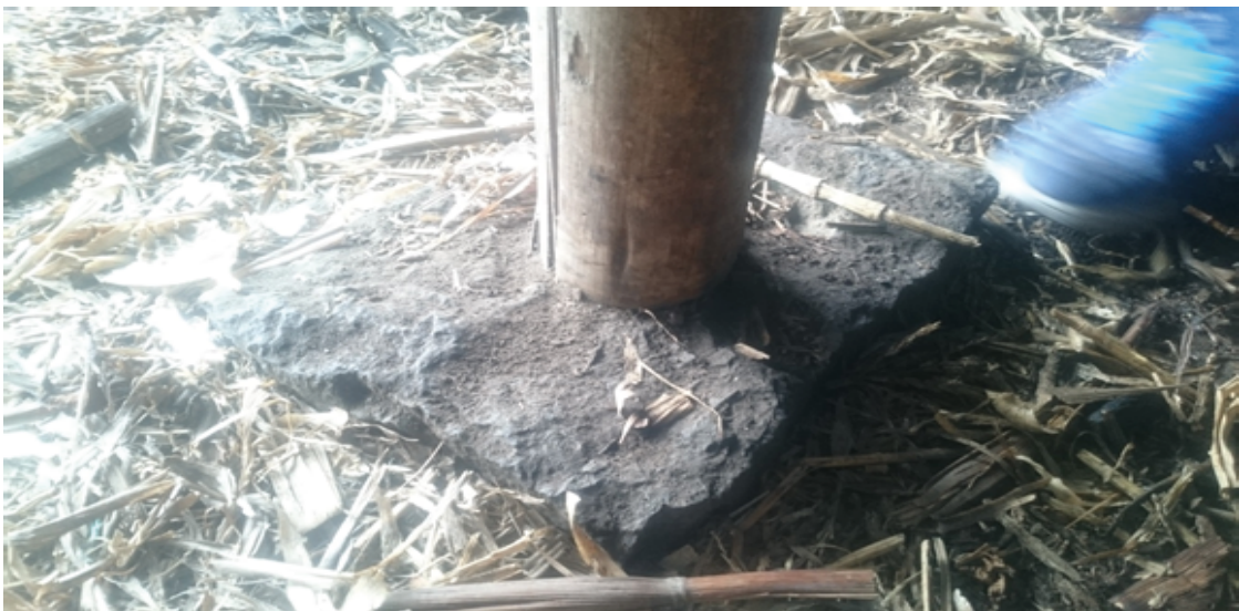
Figura 1-16 Foto del detalle de pilar asentado sobre sillar de piedra. Autor: autora y equipo de apoyo
