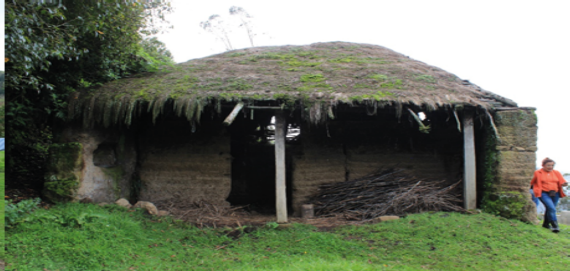
Figura 1-25 Foto de choza acoplada al declive de la montaña, el acceso es lateral para la protección del viento. Autor: autora y equipo de apoyo.
