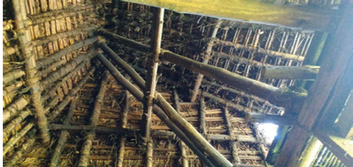
Figura 1-29 Foto de choza con la estructura en chaguarquero y carrizo hacia el interior de la vivienda. Autor: autora y equipo de apoyo.
