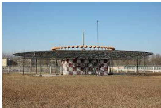
Figura 2.5. Instalaciones de un VOR en tierra
